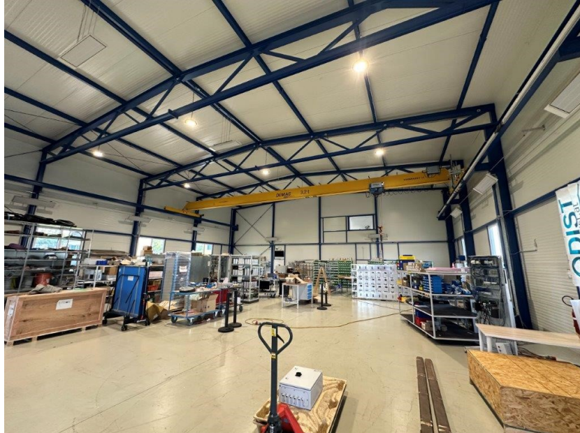
6 Halle mit Portalkran
