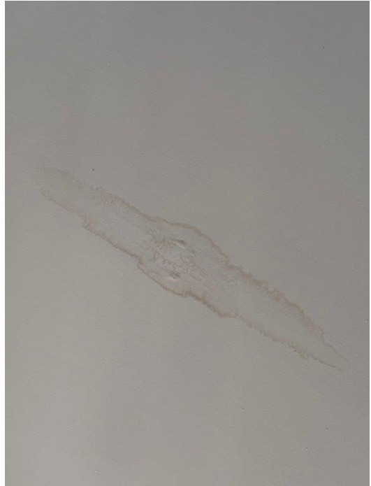
40 Schäden abgeh. Decke
