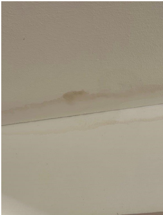
41 Schäden abgeh. Decke
