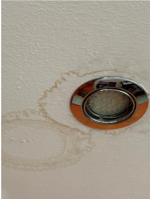
39 Schäden abgeh. Decke
